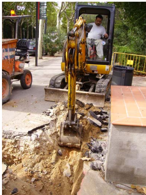
Foto 2. Màquina realitzant la rasa
