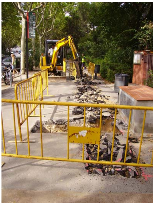
Foto 1. Màquina picant la capa d'asfalt de la vorera
